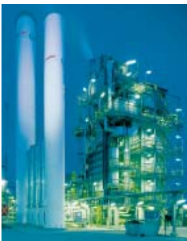
H 2 /CO-Anlage in Bernburg (Deutschland)
